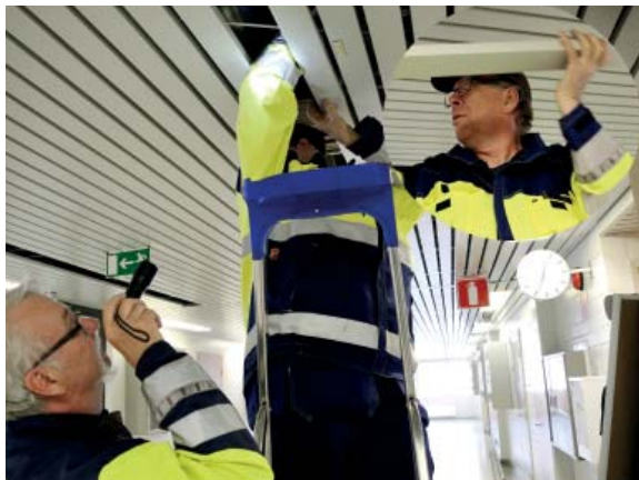
Pentti Kostamoinen ja Kauko Karhu tutkivat kasarmi 5 alakaton sisuksissa olevaa säätöpeltiä.
