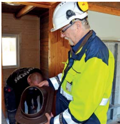
Pentti Kostamoinen katsastaa Karjalatalon viemärin tuuletusputken läpivientikappaletta.
