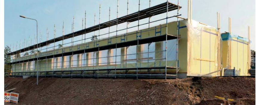
Kuljetuskeskuksen toimistorakennus nousee.
