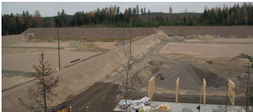
Pahkajärven ampumaradan rakennustyöt käynnissä vko:lla 42/2016 (Rata 1 vasemmalla ja Rata 2 oikealla).
