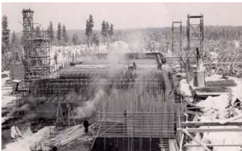
KUVA Kasarmi 2:n rakentaminen käynnissä vuonna 1965.
