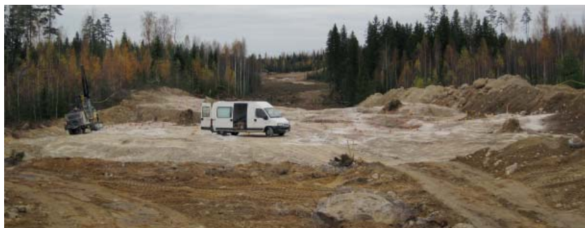
Loirintien varressa sijaitsevan 300/600m ampumaradan pohjatyöt käynnissä viikolla 42/2016.
