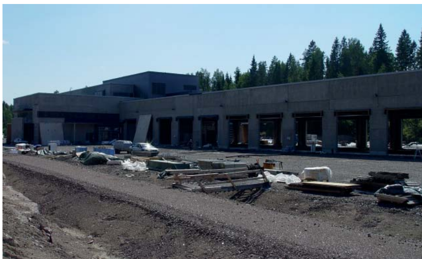
Panssarihallin rakennustyöt meneillään vuonna 2005.
