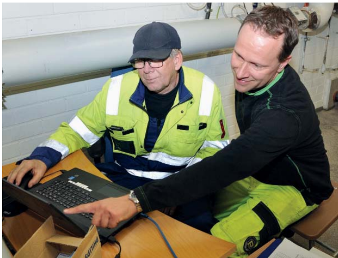
Kuva lämmönjakohuoneesta jossa vian selvittely johti mm. ilmanvaihdon käyttöaikojen muutokseen. Vasemmalla Kauko Karhu ja oikealla Jouni Kytöjärvi.
